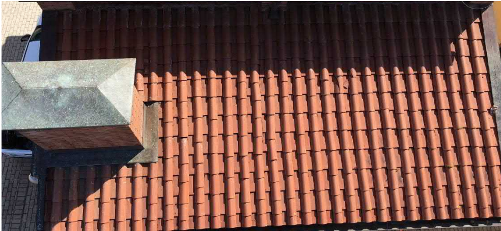
Bild 8. Nord-Dach nach der Reinigung.
