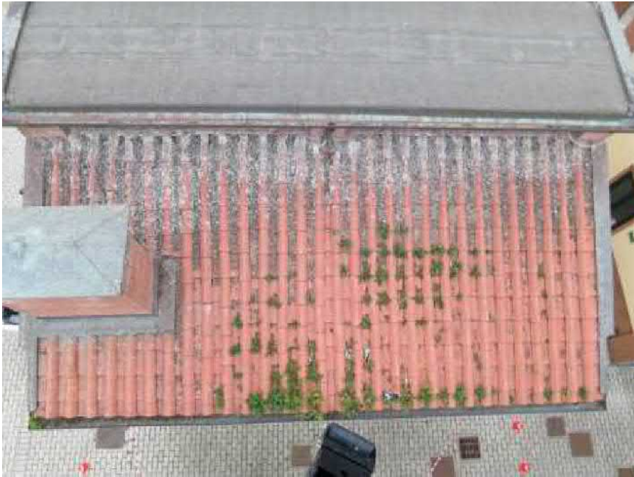
Bild 6. Nord-Dach vor Reinigung und Einsatz.
