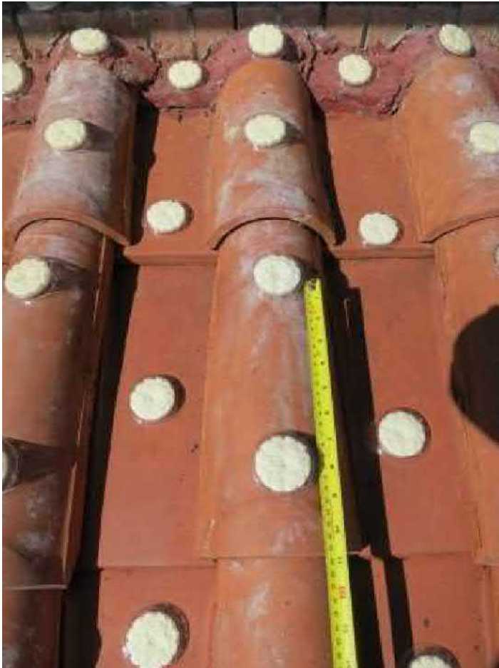
Bild 4. Auf dem Süd-Dach wurde Bird Free eingesetzt.
