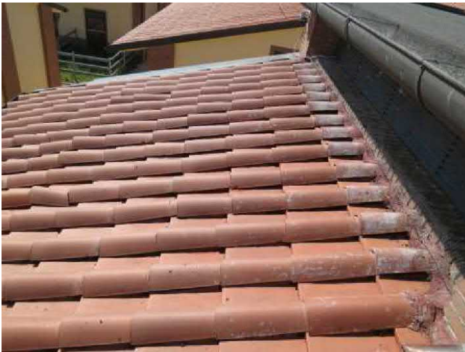
Bild 3. Süd-Dach nach der Reinigung.
