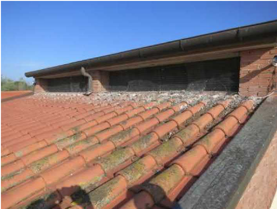
Bild 1. Süd-Dach vor Reinigung und vor dem Einsatz.
